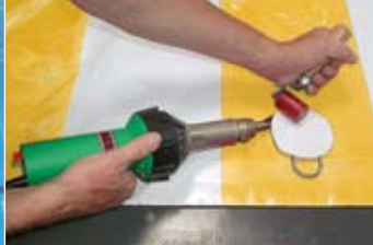
Наварка крепежной накладки при помощи ТРИАК S.
