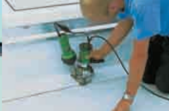
Полуавтомат ТРИАК ДРАЙВ PID при сварке кровельного покрытия около светового купола.
