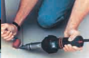
Аппарат ТРИАК PID со щелевой насадкой 20 мм и прикаточный ролик при сварке кровельного покрытия.
